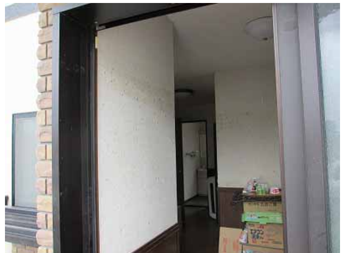
↑玄関外から撮影 水の痕が部分まで津波到達
