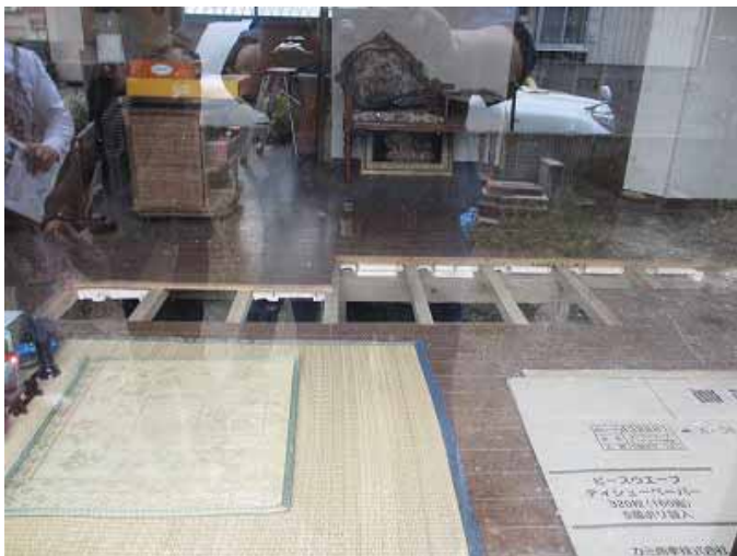
↑津波で1階浸水 漏電のため電気不通で 生活不可能
