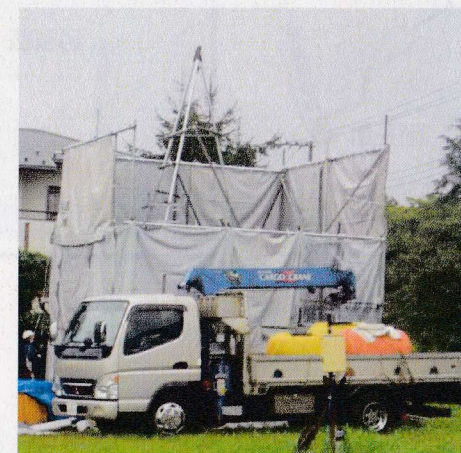
ボーリング調査イメージ
