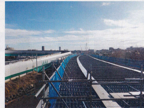
橋梁上部工施工状況(大泉JCT)
